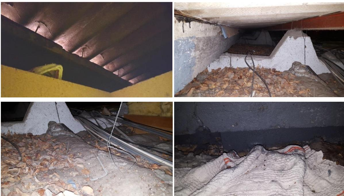
**Figure 27 : Etat du plénum situé au niveau du faux plafond présentant le développement de moisissures**
