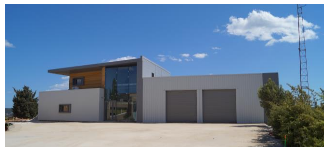
Locaux techniques Air PACA à Martigues
