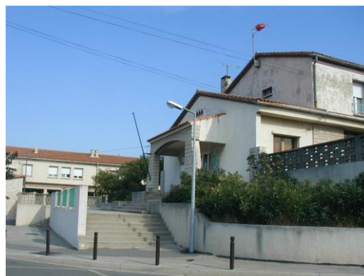
Station de mesure de Martigues / Lavéra
