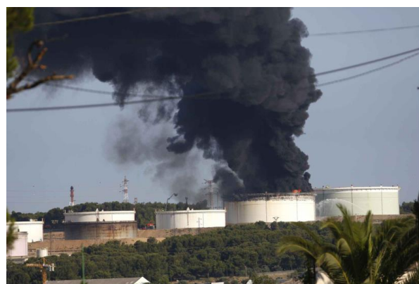
Feux de bacs de stockage, le 14 juillet 2015, à Berre-l'Etang
