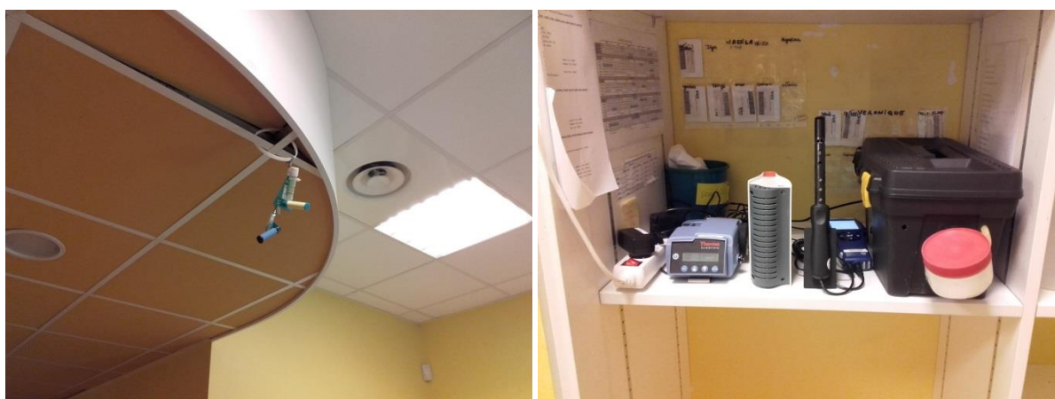
Figure 10 : Dispositifs de mesures chimiques à gauche et de particules fines, COV totaux et CO 2 à droite dans la salle n°2
