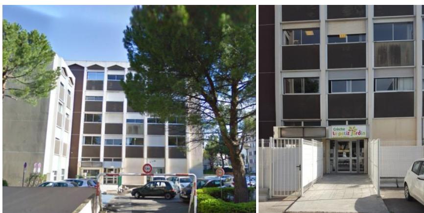
Figure 5 : Entrée située au sud du bâtiment
