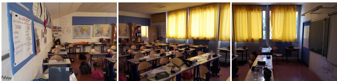
Photographie 80 : Salle de classe SDC2 de l'école Castelnor
