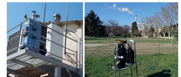
Dispositif de surveillance mis en place à proximité de l'usine Fibre Excellence.
