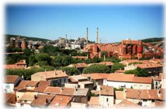
Espace pavillonnaire et industriel
