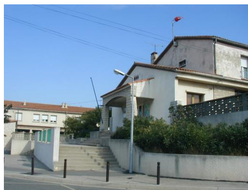
Station de mesure de Martigues / Lavéra
