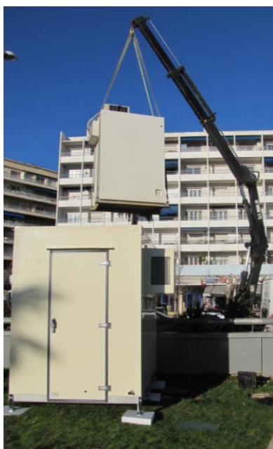
Remplacement de la cabine de Toulon Foch
