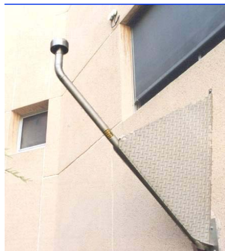
Canne de prélèvement des gaz
