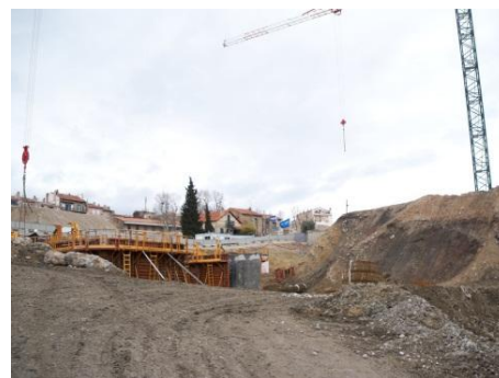
Chantier à proximité de la station Saint-Louis à Marseille
