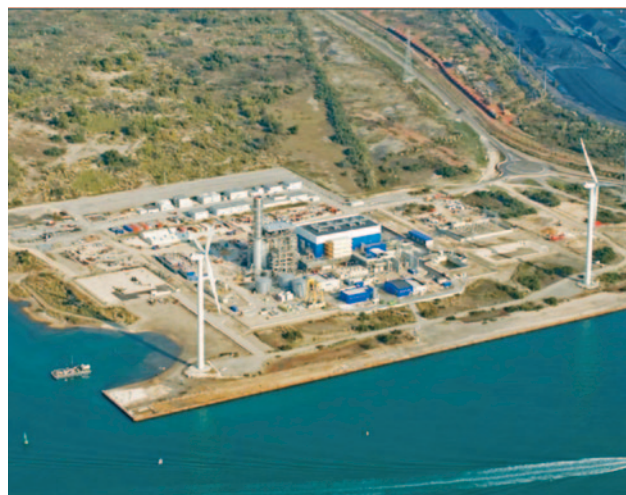
La centrale de Combigo (Fos sur Mer – 13)
