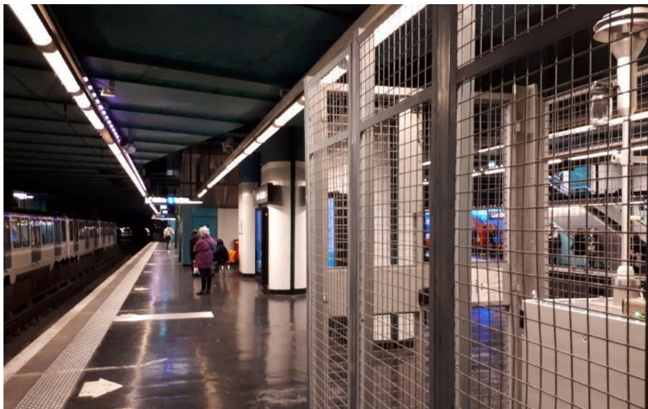
Photographie 8 : Station de mesure positionnée en bout de quai de la station Saint-Charles (source AtmoSud)
