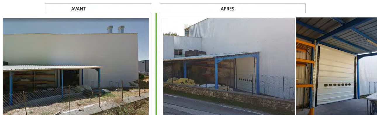
Photographie 9 : Changement de la porte donnant sur l'extérieur côté crèche Babilou par une porte automatique
