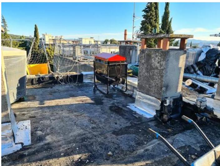
La visite du toit a permis de constater que les pièces des deux logements où les odeurs se font le plus sentir correspondent aux points bas du toit et à l'évacuation des eaux de pluies qui passent à travers le muret pour rejoindre les gouttières.
