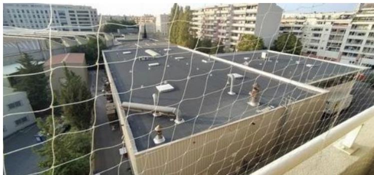
Figure 1 : Prise de vue du balcon sur lequel est situé la mesure du capteur 91
